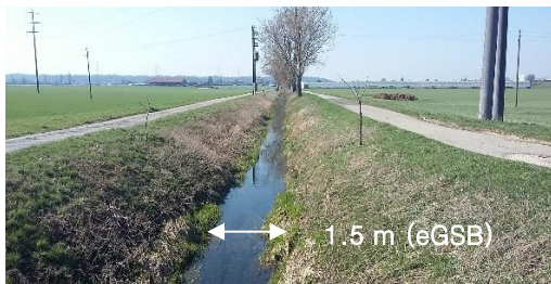
Abb. 1 Beispiel einer Berechnung der natürlichen Gerinnesohlenbreite
